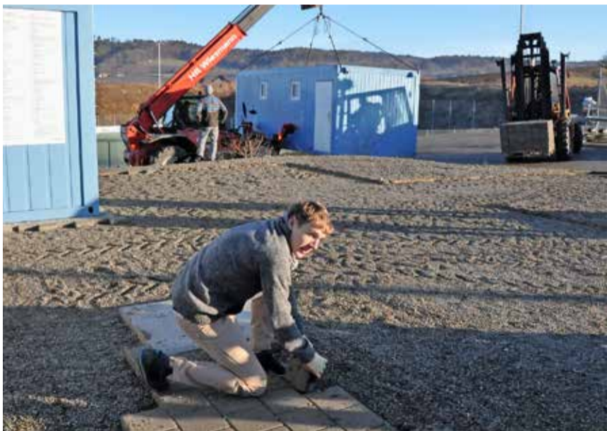
Abbrucharbeiten stehen dieser Tage beim Fussballplatz Schelmengrueb an. Bild M. G.
